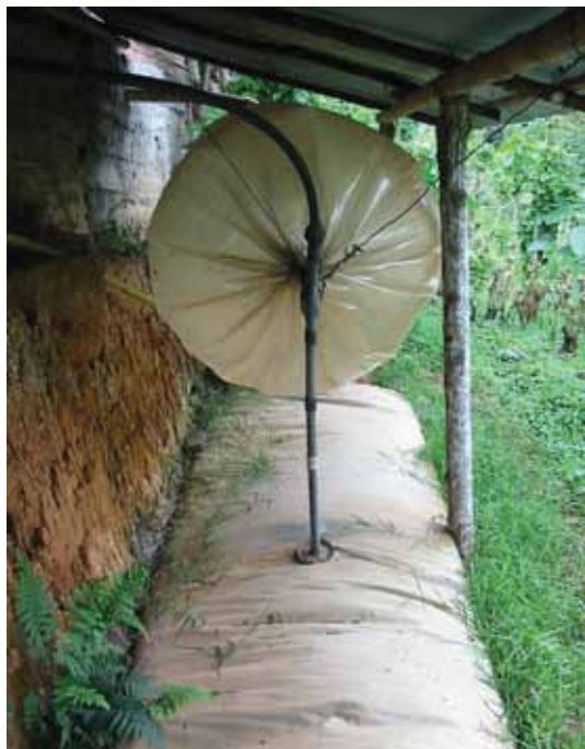
Foto 7. Biodigestor plástico de flujo continuo. Finca Villa Victoria, Dagua, Valle del Cauca
