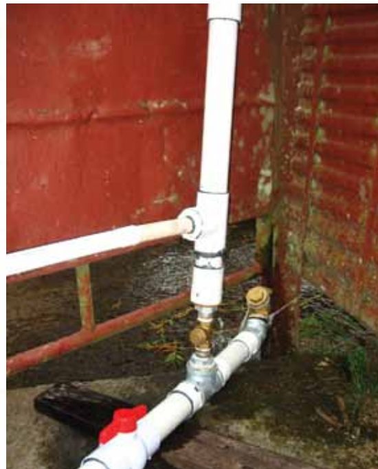
Foto 35. Ariete tipo “Chapaleta” para bombeo de agua Foto: Andrés Zuluaga.
